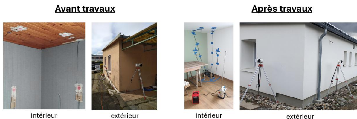
Figure 72 : Photographies avant et après travaux des mesures locales d'isolation thermique du chantier à Chambéry
